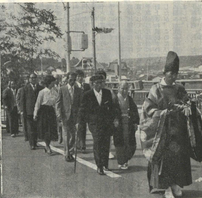
写真左は金田大橋全影 9月30日 写真上は渡り初め風影
