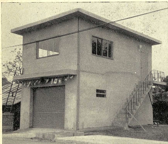
新築された第3分団消防倉庫
