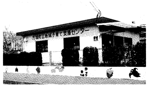
中央保育所の園庭に建てられた子育て支援センター
