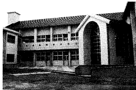
平成7年度改築されてきれいになった弁城小学校
