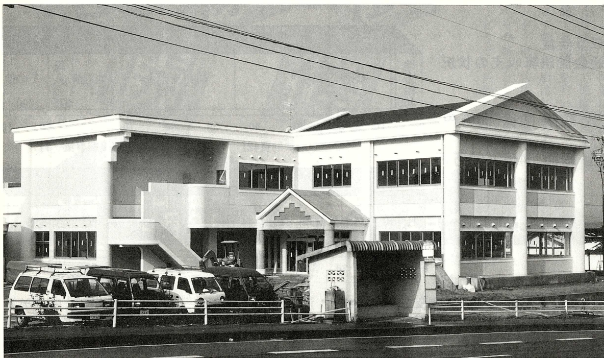
完成間近の「方城町立保健福祉センター」
