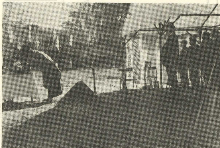
起工式 と ところ 昭和47年12月5日 町民グラウンドよこ建設現場
