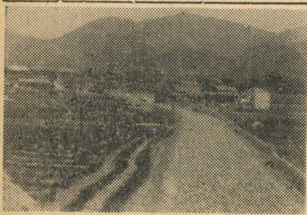
【完成した新町線道路】
