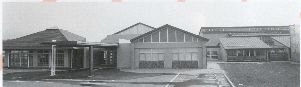
↑新しくなった上野小学校校舎の管理棟と教室棟の一部。現在は右側にある旧校舎と体育館の解体工事が行われている。
