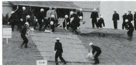
↑斜面の崩壊と透水を防ぐ「シート張り」の水防工法。
