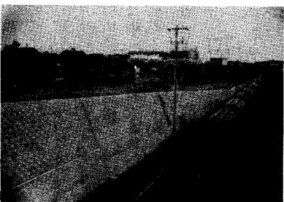
【昭和56年度から58年度まで3ヵ年計画で工事が進む町道二反ヶ浦～松本線道路改良工事】
