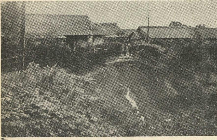
写真は集中豪雨で崩壊した徳人原の道路
