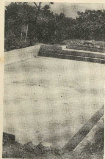
完成されたプール
