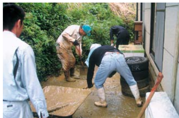
↑ 互いに協力をしながら、民家に流れ込んだ土砂を撤去するボランティア。
