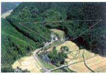
伊良原ダムの建設予定地
