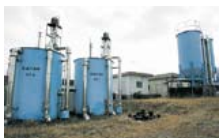
以前稼働していた神崎浄水場
