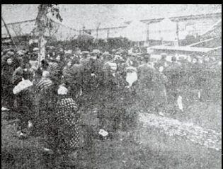
レンガ塀が衝撃で壊れ、坑木が噴き上げられた坑口（写真左）。事務所前には犠牲者氏名の揭示場が設けられた（写真上）。写真／福岡日日新聞（西日本新聞社の前身）
