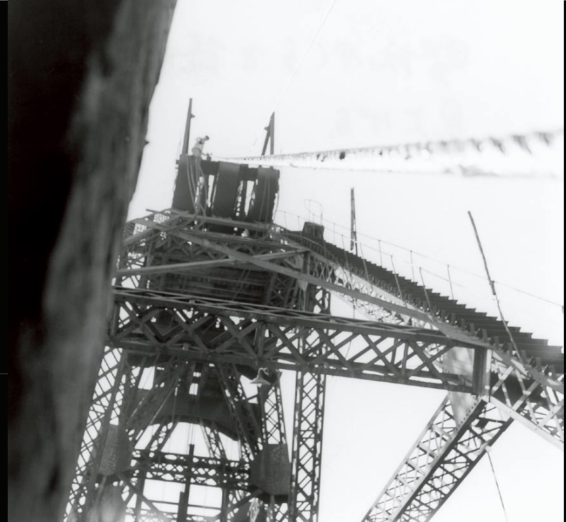
↑昇降口から見上げた豎坑棚。ここから坑底までは地下およそ270mもあった。234mの福岡タワーより36mも高い位置から夏みかんが投下されたことになる。
