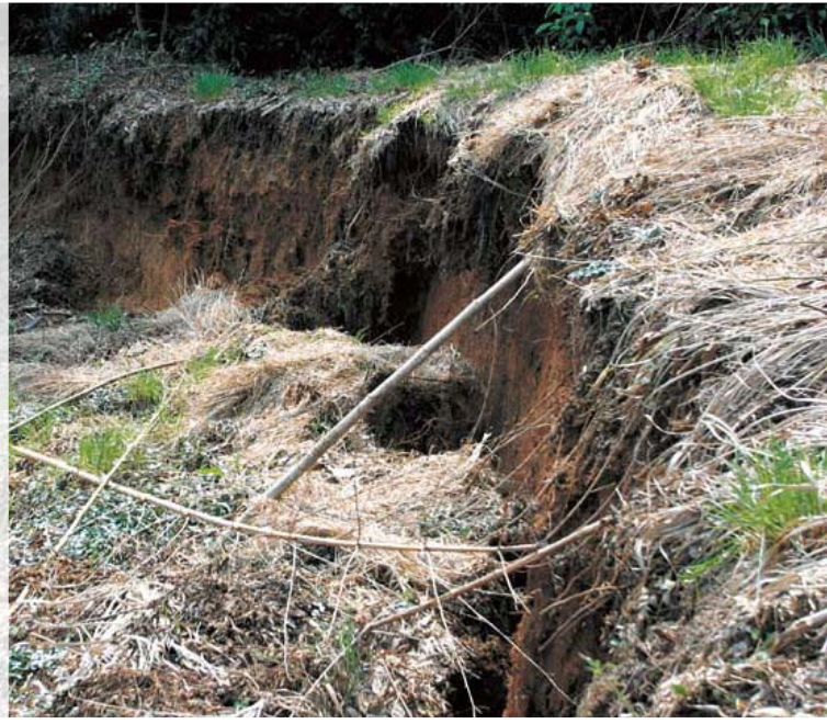
7.19の豪雨で崩落した町内の斜面
