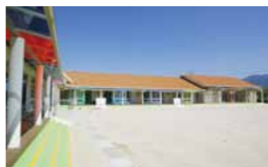
運動会も楽々行える広い運動場。園児が所狭しと走り回れるよう、旧園舎の解体工事後は、さらにその面積が拡張されます。
