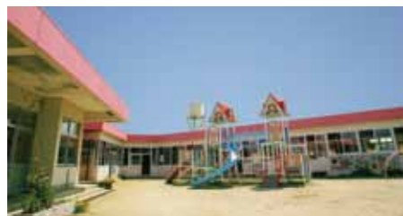
昭和51年に建設された神崎保育所の旧園舎。惜しまれつつも、10月から解体工事が行われる予定で、その後グラウンドや園庭の一部として生まれ変わります。
