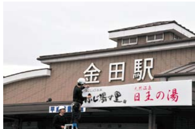
↓4月20日、金田駅正面に設置された「ふじ湯の里・日王の湯温泉」の看板。
