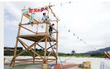
肩を落として...やぐらの撤去作業
