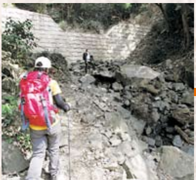
10分ほどで砂防ダムの所を通過する。
