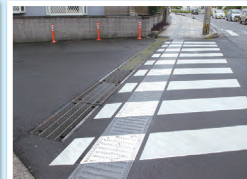
道路と歩道の段差がない
