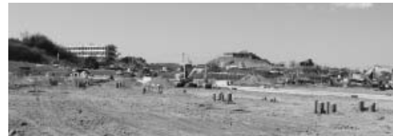
▲平原団地建て替え箇所。老朽化による建て替え工事で、準耐火構造木造平屋建て12棟24戸を建築し、平成23年度中に完成予定。
