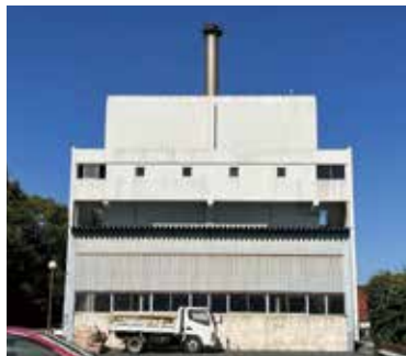
▲下田川清掃センター
