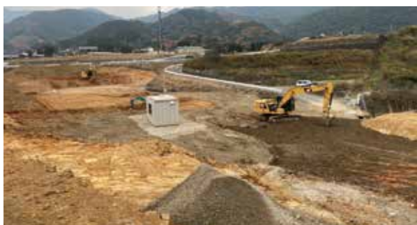
▲基盤整備工事の様子
