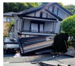
熊本地震で倒壊した家屋
