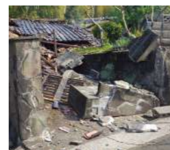
熊本地震で倒れた門柱と塀
