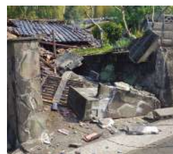
熊本地震で倒れた門柱と塀
