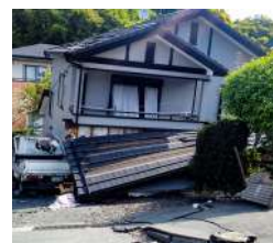
熊本地震で倒壊した家屋
