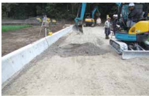
▲町内の工事をしている様子
