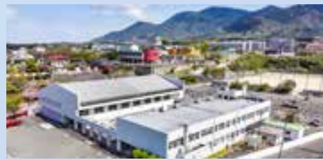
↑建設予定地は旧方城分館・方城体育館周辺。令和7年4月、第一歩となる既存施設解体がスタートしました。
