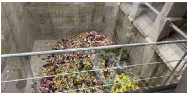
▲新ごみ処理施設の内部
