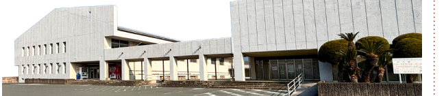
↑長年の役目を終え、今回解体を行う方城体育館と旧公民館 方城分館
