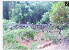
1 長さ20m以上の木が倒れて道路をふさいだ、国道500号の中河原町バス停付近で発生した土砂災害。 2 罹災建物の裏にある小さな川に土砂が流れ込み、その土砂がさらに広範囲で流れ込み本流の彦山川にも流入。 3 日田彦山線の線路土手が全て流され、宙に浮いた線路。
