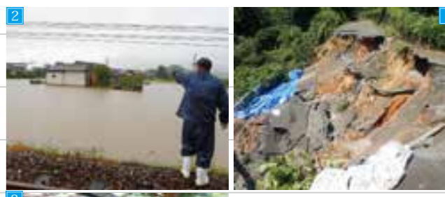
① 弁城地区で道路崩落の土砂崩れ ② 草場地区(市場)は広い範囲で冠水し、2軒が孤立 ③ 宝見保育園(金田)で浸水が発生。土のうで流入防止 (全て平成30年7月豪雨時の福智町の災害現場の様子)
