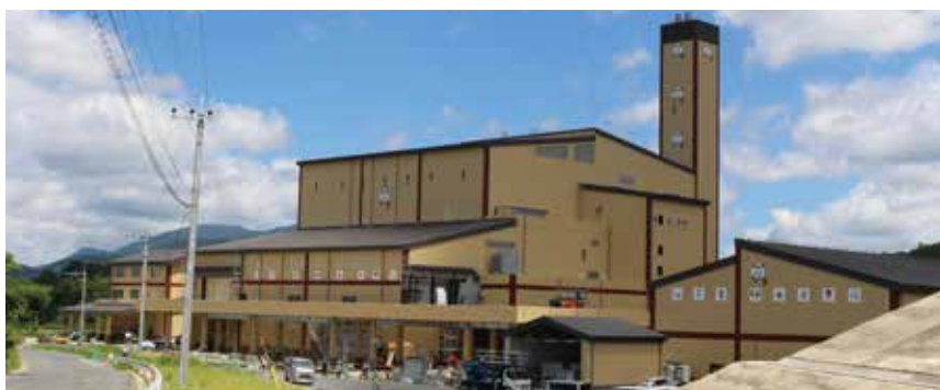
▲建設中の田川地区新ごみ焼却場
