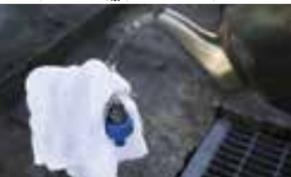
水道管にタオルなどをかぶせて、ゆっくりとぬるま湯をかけます。熱湯をかけると、水道管が破裂する可能性があります。
