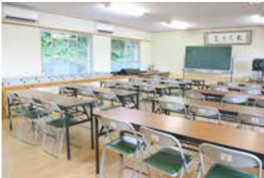
← 空調設備は、熱中症対策として初めて設置。
