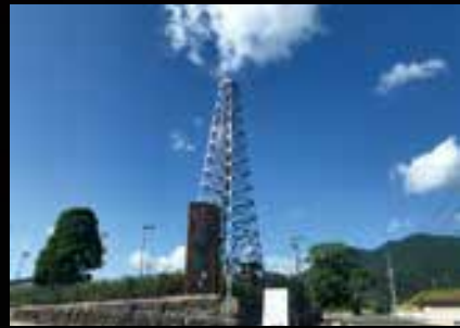
↑本年度、民間移譲に向けてポンプの清掃やケーブル交換工事を行い、開業当初の泉質を取り戻した。
