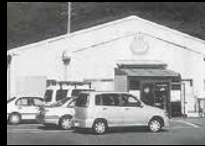
↑ふじ湯の里完成前の4年5か月間、運営した仮設温泉。当時からその良質な泉質が評判だった。
