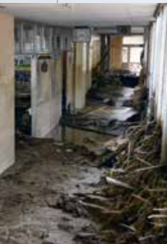
↑土砂と流木が流れ込んだ体育館(上)と校舎(下)。体育館がせき止めなければ、校舎も危険にさらされていた。
