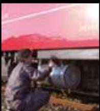
高級感ある光沢レッドは自社が追求した提案色。ボディー下部の通常は塗らない機械部分にまで入念に塗装。精力的な作業で2か月の工期内に完成させた。
