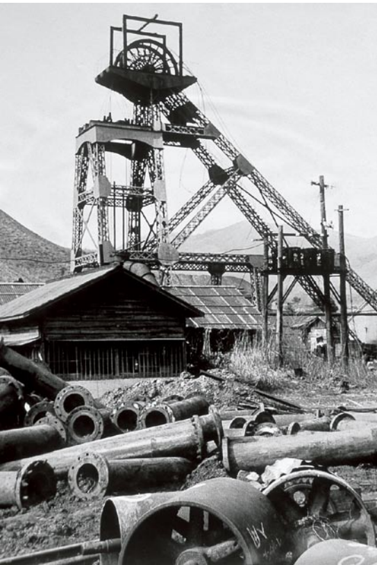
三井田川、日鉄二瀬とともに明治期の「日本三大堅坑」とされた三菱方城。当初その規模は鉱業界を驚かせた。明治45年に発電所を開設し、出炭量をさらに伸ばした。
