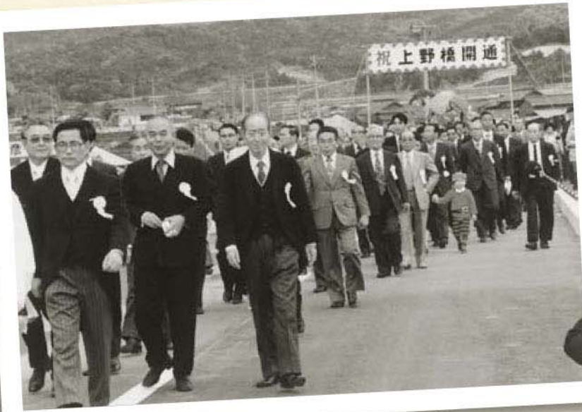
上野地区と赤池地区をつないだ上野橋の開通、総工費は約6億円
