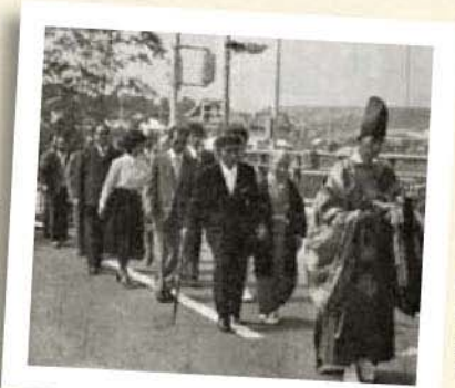
◀ 平原田川線道路を川筋の県道とつないだ金田大橋の渡り初め
