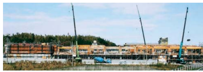
本年度中の完成をめざして建設が進む新校舎、建設費は約10億7千万円。奥に見えるのが現在の校舎。
