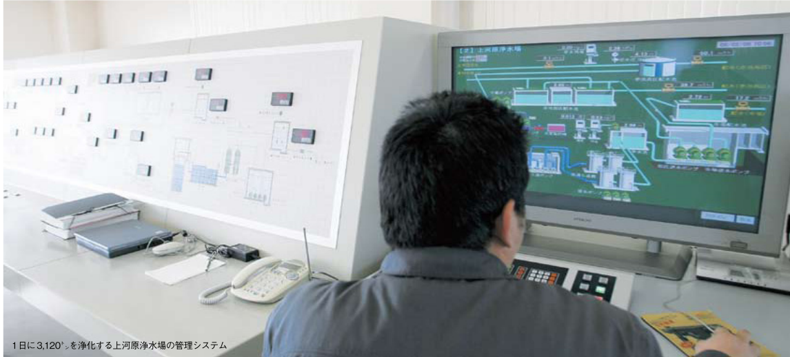
1日に3,120 3 を浄化する上野原浄水場の管理システム
