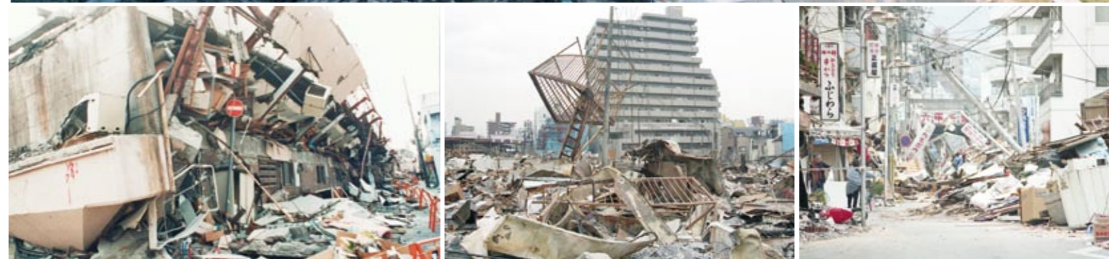
▶ 「阪神・淡路大震災」は、平成7年1月17日に発生した「兵庫南部地震」による大規模地震災害。地震の規模はマグニチュード7.3、最大震度7。発生当時、戦後最多となる6,434人の死者を出し、家屋だけでなく、鉄道や高速道路なども甚大な被害を受けました。(写真提供・神戸市)
