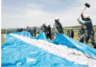
豪雨の氾濫を想定し、6月1日に河川敷合流地点・金田で行われた水防演習。福智町・香春町・糸田町の各消防団、国土交通省、田川地区消防本部から約150人が参加。改良土の工法やシート張り工法を連携して実践し、中村団長が総括指揮、浦田町長が演習本部長を務めた。
