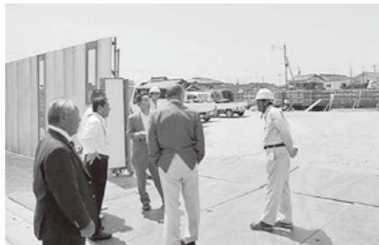
▲ 宝見団地建設現場
