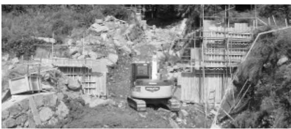
▲弁城地区にある岩屋川。平成21年の集中豪雨により、護岸・河床が破壊的な被害を受けたため、現在、災害復旧中。
