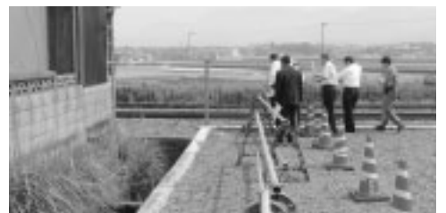
▲道路は拡幅工事（交差点）を行う。水路は老朽化に伴う改修工事で、平成21年度からの継続事業であり、下流合流点まで行う。
