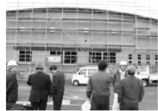
【付託案件】 議案 第83号 ▲給食センター建設工事現場
