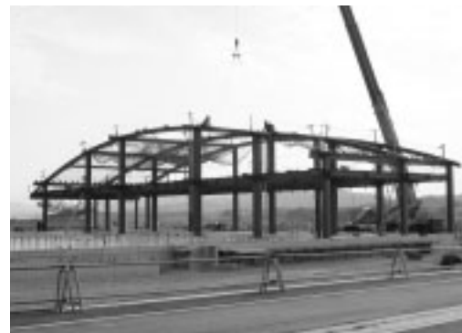
▲給食センター建設工事現場(H21.10月中旬現在)
