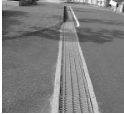
▲町内全域で盗難被害にあっているグレーチング
