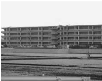
平成17・18年度で建て替えられた小豆田団地
