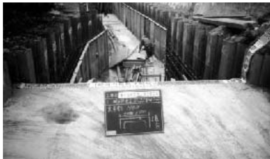
ボックスカルバート...中に埋設される箱型の構造物で、水路等の収容など各種の用途に使用されます。
