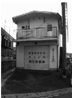
消防団員の駐車場がない第3分団格納庫
